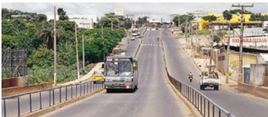
Em corredores exclusivos os articulados aumentam a capacidade de transporte
